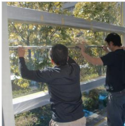
スポンジバー工法
