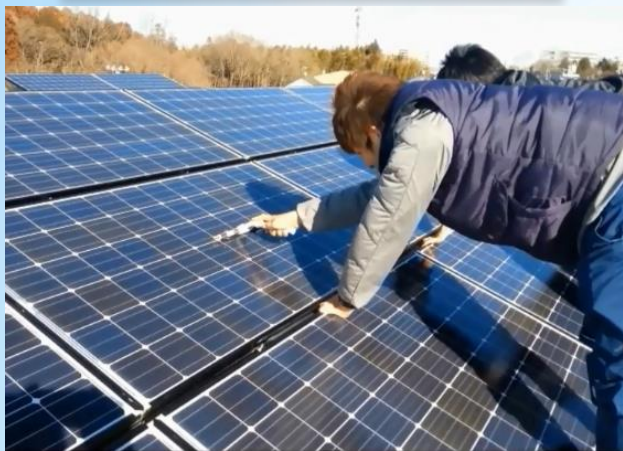
茨城県にて100㎡施工
