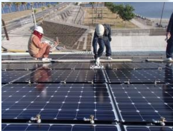
鹿児島県にて310㎡施工
