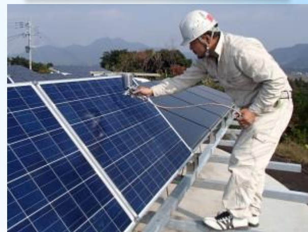
鹿児島県にて70㎡施工
