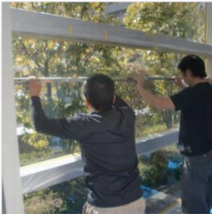
スポンジバー工法
